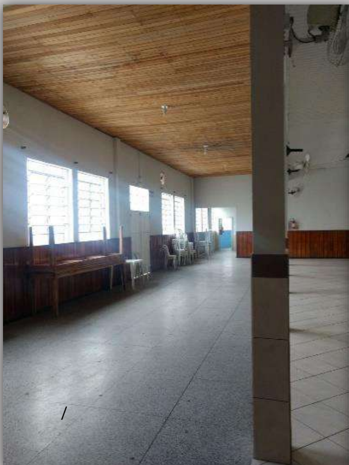
Parte da forração em madeira sendo substituída, os cupins estão na maior parte da construção Fonte: O autor, 2018
