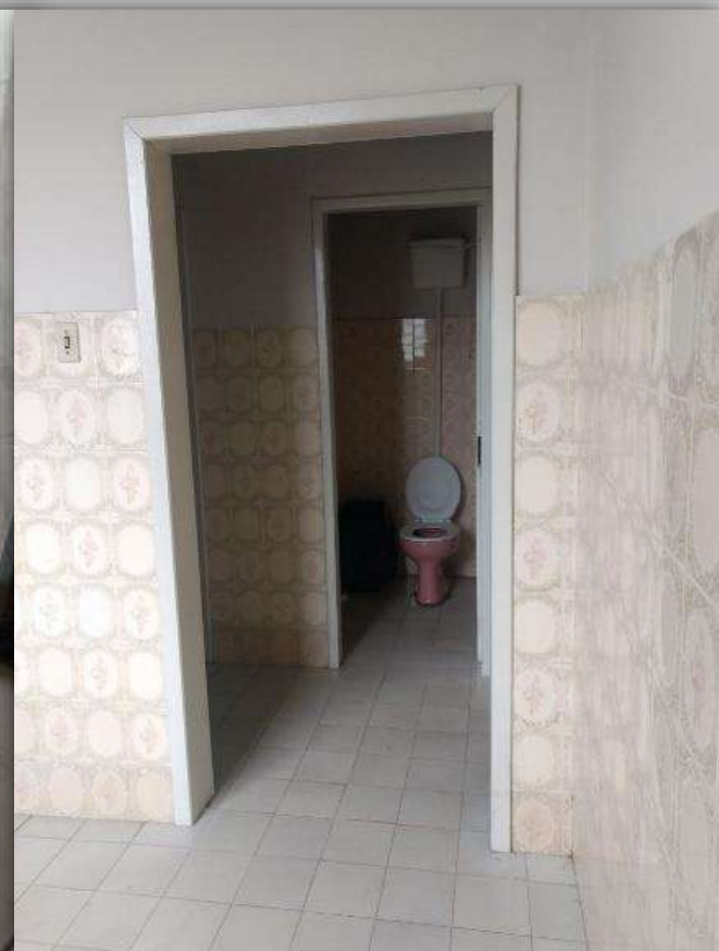
Descontinuidade e má conservação na paginação dos revestimentos internos- Fonte: O autor, 2018
