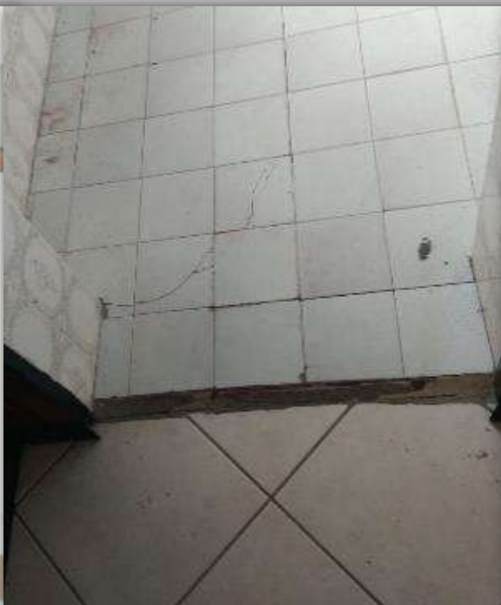
Descontinuidade e má conservação na paginação dos revestimentos internos- Fonte: O autor, 2018
